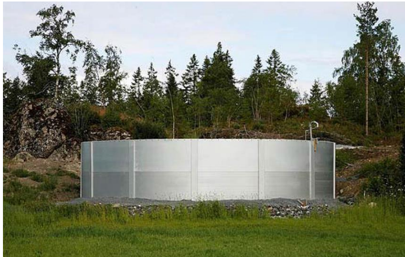
Figur 2: Lagertank i stål.
