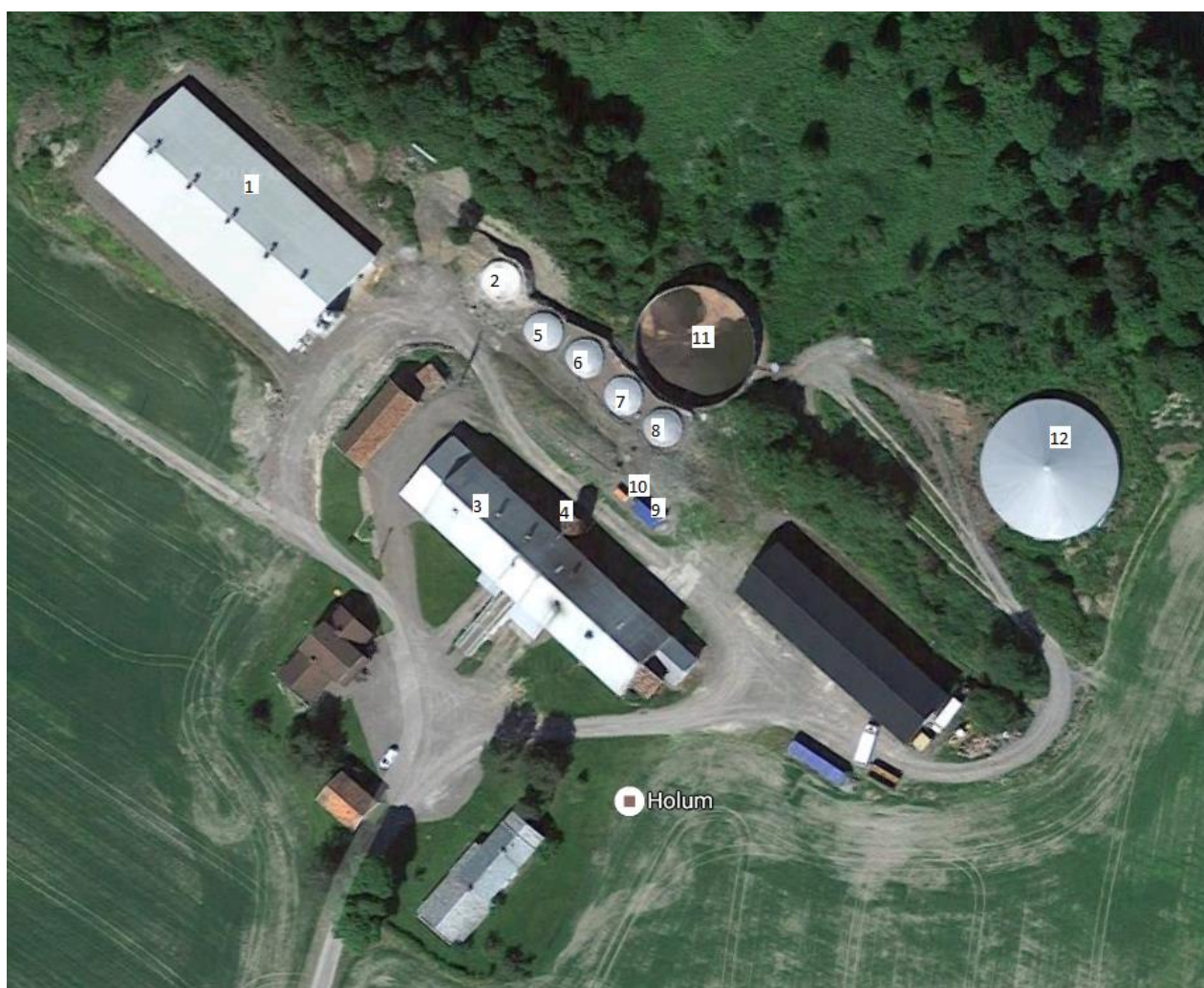
Figur 1: Oversiktsbilde Holum gård. Kilde: Google maps, earth. Nummereringene refererer til: (1) Nytt grisehus. (2) Fortank grisegjødsel. (3) Tidligere fjøs. (4) Fortank matavfall. (5-8) Reaktor 1-4. (9) Teknikk-container. (10) Container CHP. (11-12) Lagertank 1 og 2.
