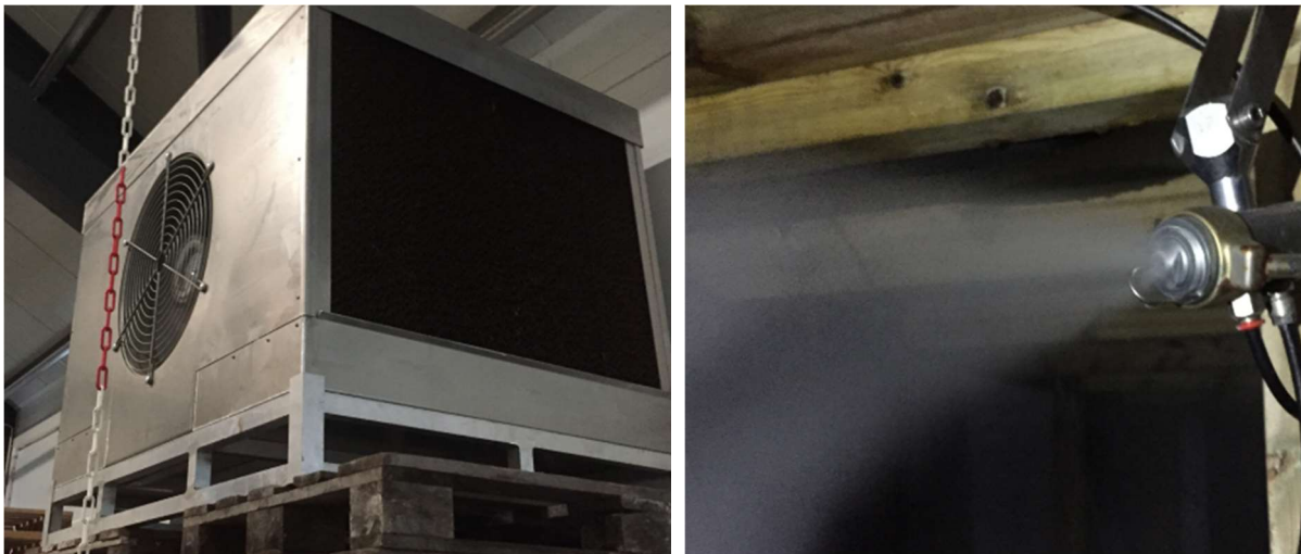
Figur 23: Ulike måter å oppfukke lagerluft: Oppfukning av membrankassett med vifte (t.v.), og tåke/dysespredning (t.h.)
