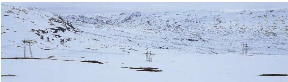
Bilde 2. 420 kV kraftledningen som krysser over Rostafjellet (foto: Sindre Efterstøl)
