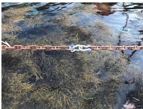
Figur 3i. Reparasjon av brudd i ankerkjetting etter høye vinder.
