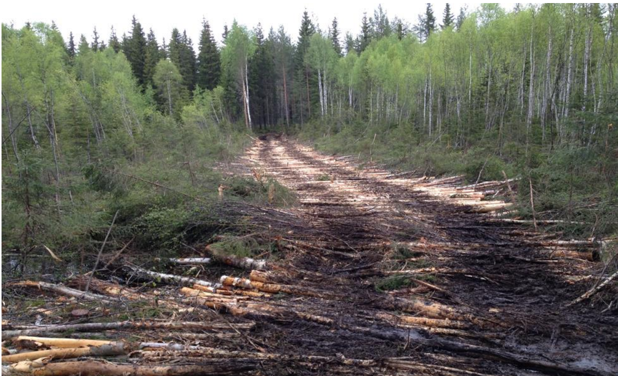
Figur 24. Kavlelegging av myr med virke hentet i traséen.
