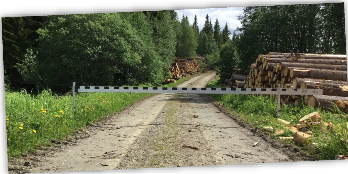
Bilde 8: Skogsbilveiene er avgjørende for skogbrukets lønnsomhet. Dessverre er mange veier, i sin tid, bygd opp av stedeigne masser for transport med kortere og lettere tømmerbiler, samt for et annet klima. Bæreevneprosjektet skal hjelpe å planlegge fremtidens drifter for å prøve å unngå ødeleggelse av veier ved feil bruk (bruk til feil tid)
