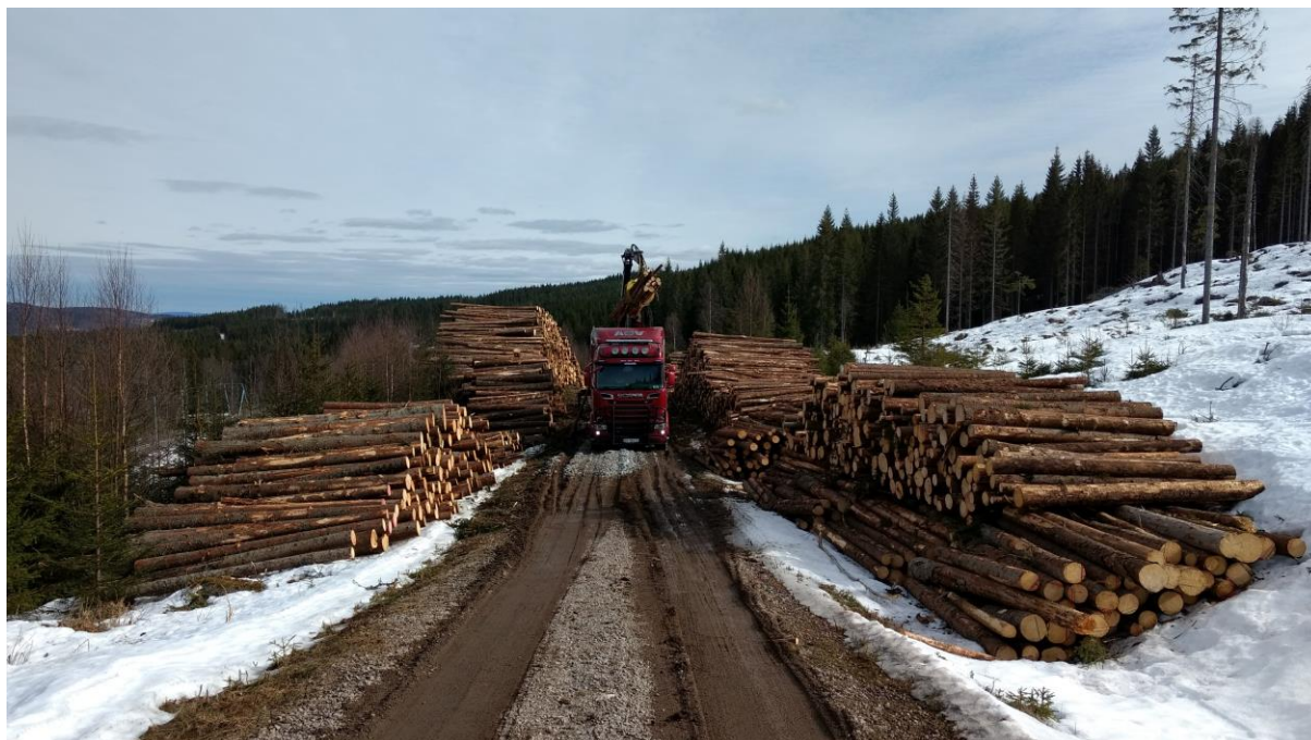
Bilde 7: Utkjøring av tømmer til feil tider kan gi store behov for reparasjoner på veinetet. Få veier i Skandinavia har en god nok standard til å kunne benyttes hele året. Bilde: Romeriks allmenningene v/ Johannes Enersen
